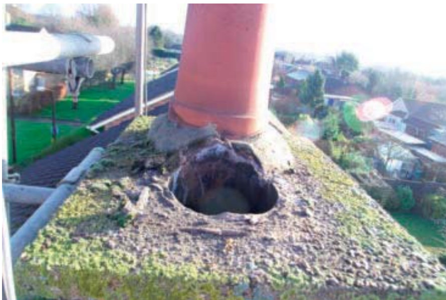
Figuur 12.2 Afbreken van de grès uitmonding. (© Muelink & Grol)
