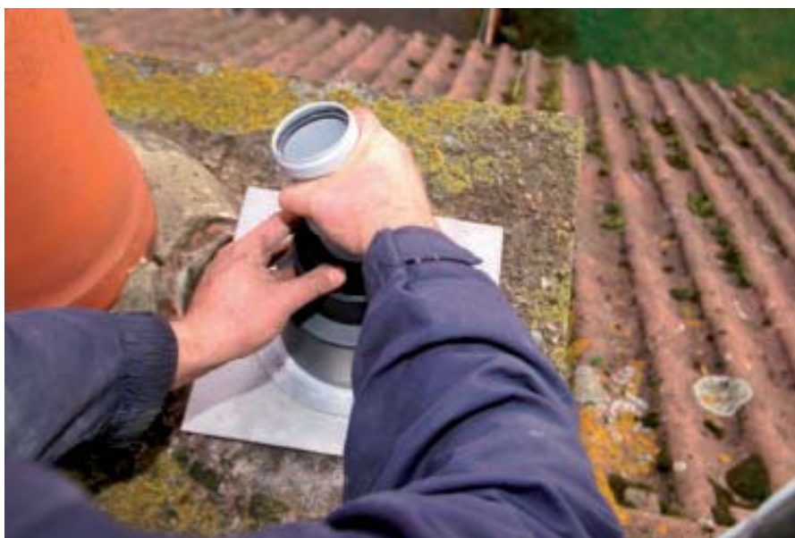
Figuur 12.3 Bevestigen van de grondplaat en aanbrengen van de tubering. (© Muelink & Grol)
